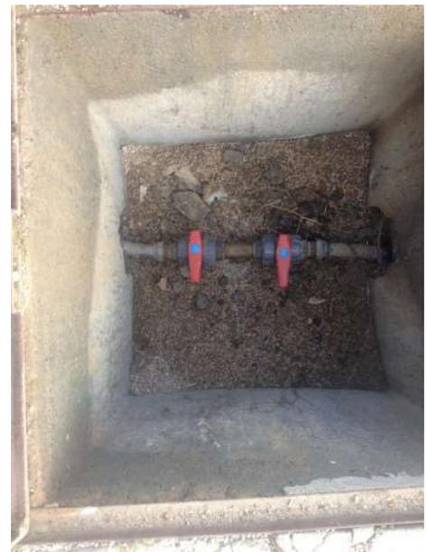
En el 2010, dentro de las obras de canalización y pavimentación de la localidad, se instaló un sistema de riego independiente de arbolado y zonas ajardinadas. Dicho sistema se conectó a la conducción y depósito de agua de riego, rehabilitado en 2008.
